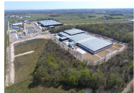
Vue aérienne du site - Crédits : GSE
